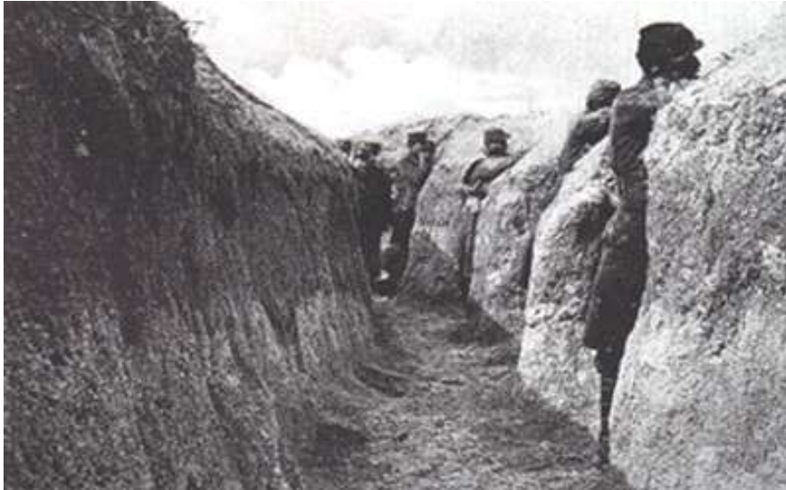
Premières tranchées - photo http://www.premiere-querre-mondiale-1914-1918.com "
